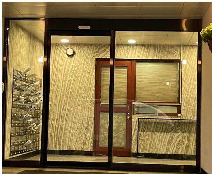
공용현관 출입문 (포항공대 교수아파트)
